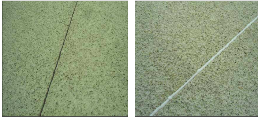
Imágenes 5 y 6 Detalle del sellado entre paneles
